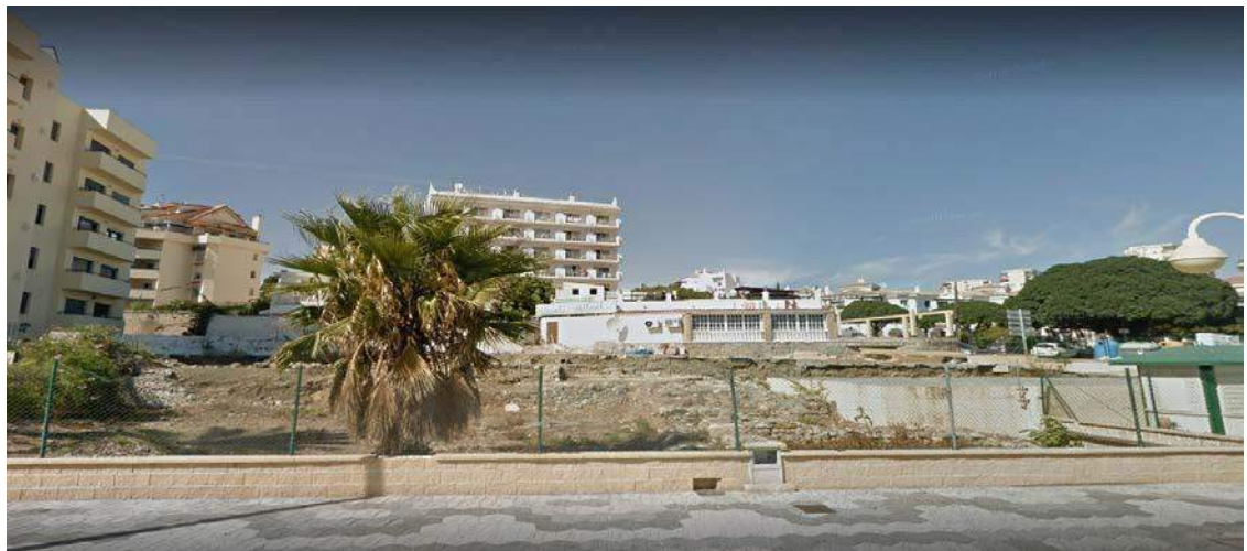
Figura 4. Vista del estado actual del yacimiento Villa romana de Los Molinillos , Benalmádena (Málaga, mayo de 2021).
